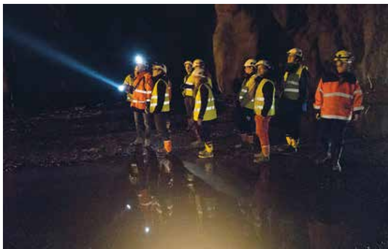
KTK:n jäseniä ihmettelemässä rakenteilla olevan länsimetron tunneleita. (Kuva: Ari Hartikainen, 2013)
