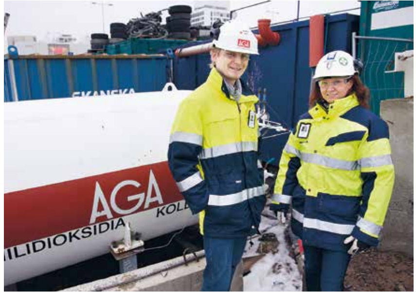
Skanskan Kirsi Savikurki ja AGAn Antti Hämäläinen pohtivat poistovesien hiilidioksidineutralointia Länsimetron Tapiolan louhintatyömaalla.
