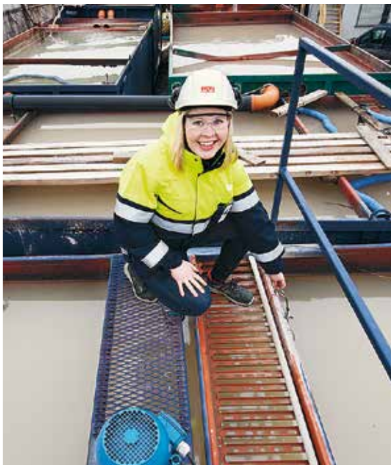
Elina Kallio-Sihvonen AGAlta esittelee Skanskan Tapiolan metrotöyrymaalla neutralointiallasta, jonka pohjalla on SOLVOCARB B -liuotusmatto.
