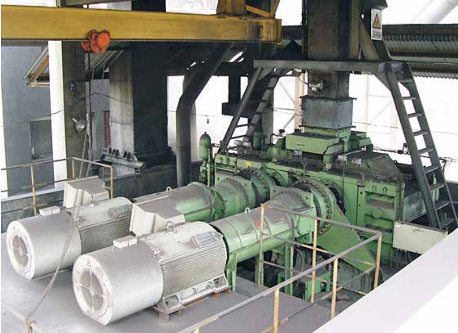
HPGR 7-140/80 palamurskausapplikaatio, Empire Iron Ore Mine, USA
