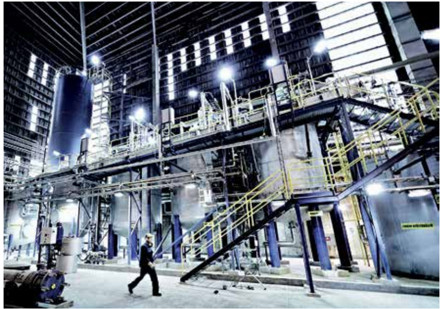
Kuva 1. Boliden Harjavallan rikkihappotehtaiden lauhteenkäsittelyprosessi. Keskellä saostusreaktorit (3 kpl). Kuva Boliden Harjavalta.
