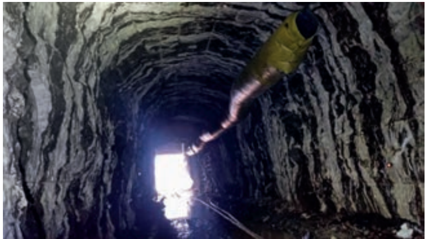
Kuva 2. Alkuosaltaan Sumppi-tunneli on hyvälaatuisessa apatiittimalmissa, joka tullaan aikanaan louhimaan louhoslaajennuksen edetessä pois.
