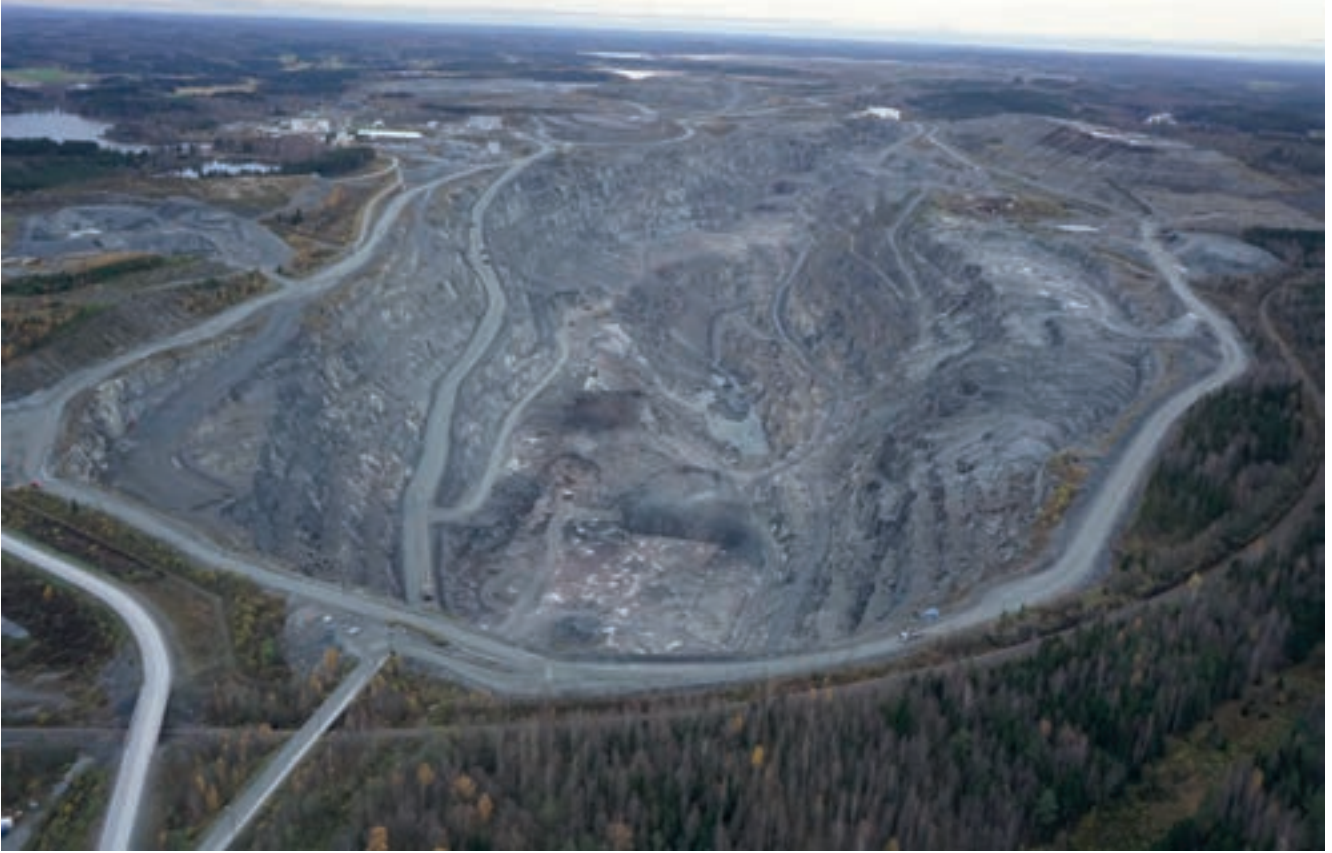
Kuva 1. Yara Suomi Oy:n Siilinjärven kaivoksen päälouhos lokakuussa 2017. Sumppi-tunnelin suuaukko louhoksen pohjalla (oikealla reunalla).
