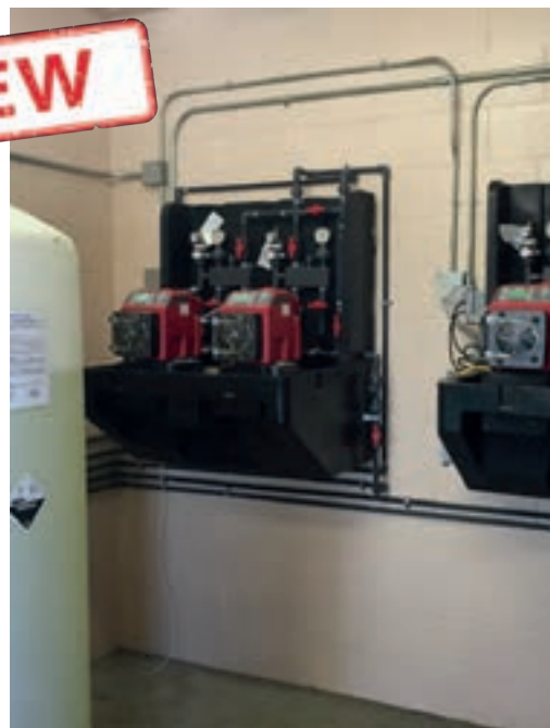
Pumppausjärjestelmä asennettiin Camdenin vesilaitokselle estämään kemikaalivuodot.
