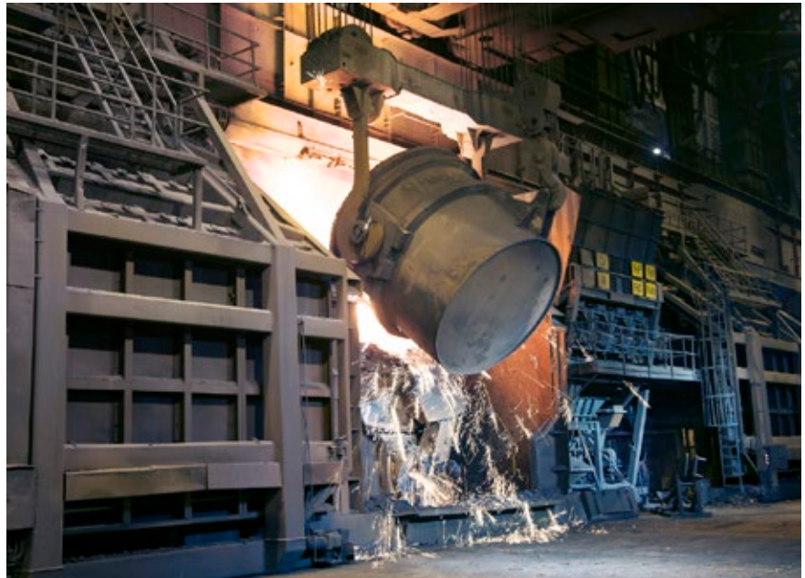
LD-konverterin panostus Raahen terästehtaalla.
