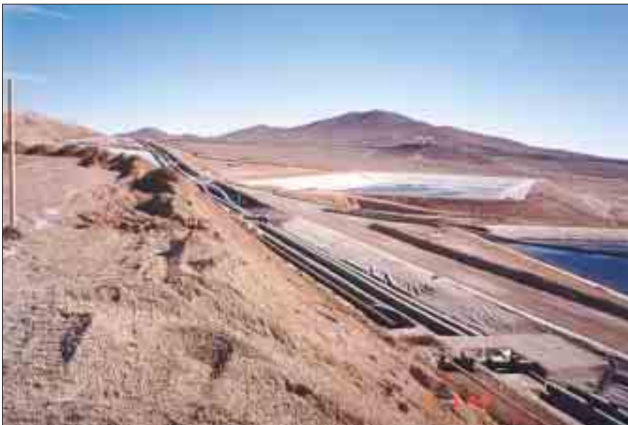
Kaksivaiheisen liuotuksen IPLS-altaat. Liuosputket kulkevat kuvan keskellä.
