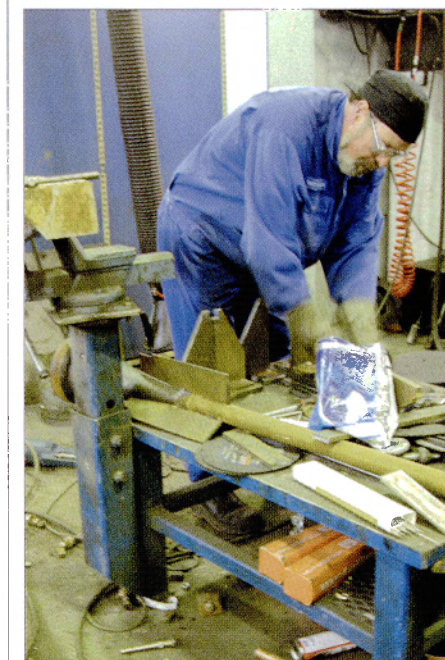
Matti Heikkilä kunnostamassa jäähditysvesijärjestelmää.
