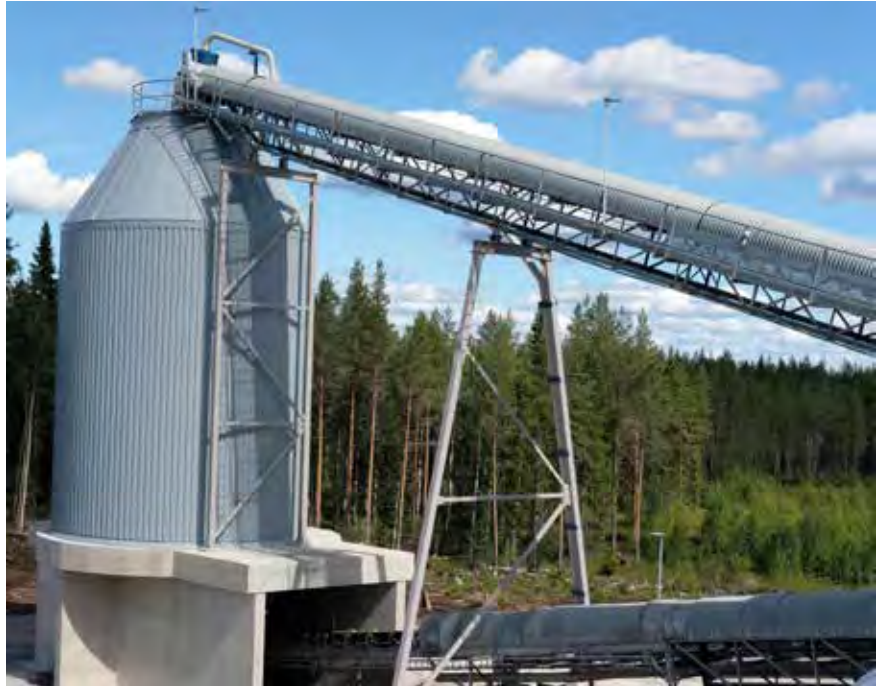
Murskausvaiheiden jälkeen jauhinmyllyihin syötettävä malmi varastoidaan omaan siiloonsa.
