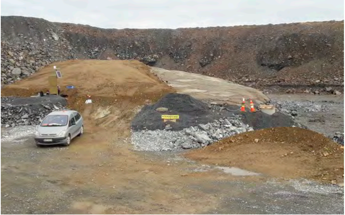
Kuva 2. Tapojärvi Oy:n toteuttama geopolymeerikoerakenne Kittilän kultakaivoksella
