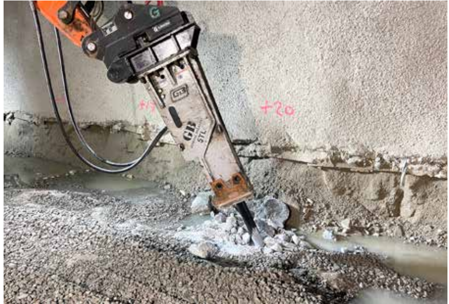
Kovien poistoa Tottolan tunnelin pohjasta Rantaradan liikenteen kesäkatkon aikana
