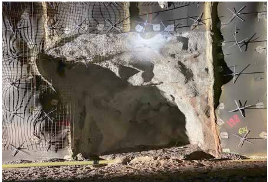
Vanhaa verhoilurakennetta verkotettuna kuprikan kohdalla Tottolan tunnelissa. Oikea puoli vielä verkottamatta, päälle asennetaan ruiskubetoni.
