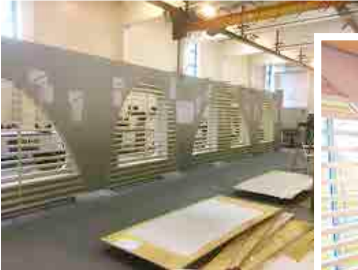
Kuva 4a. Alumiininen tilaelementti valmistusvaiheessa
