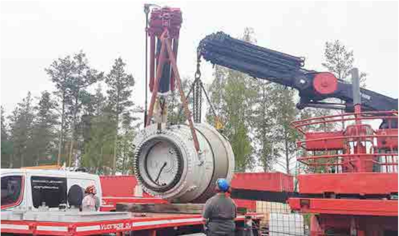
Kuva 3. Tuuligeneraattorin purkupilotissa purettiin WinWindin 1 MW generaattori, jonka hallittuun nostamiseen tarvittiin kaksi nosturia. Noin 20 tonnia painava generaattori sisälsi 250 kg NdFeB-magneetteja.
