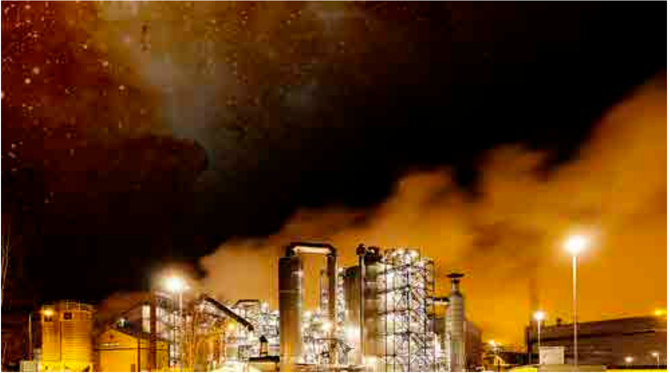
Boliden Harjavalan uusi rikkihappotehdas edustaa alan viimeisintä ja ympäristöystävällisintä tekniikkaa.
