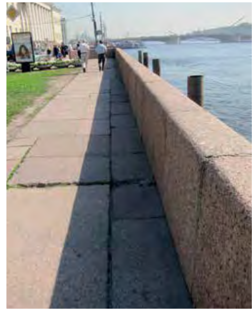
Kuva 4. Neva-joen rantavallit ja penkereet on pääosin tehty Virolahden punaisesta pyterliitistä.
