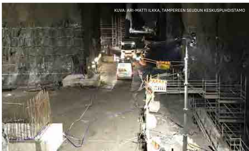
Näkymä puhdistamotilojen käytävälle. Raudoitus ja betonityöt käynnissä
