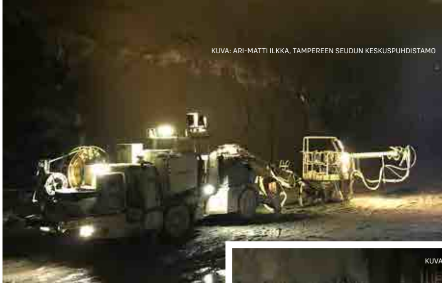
Ruiskubetonointi käynnissä
