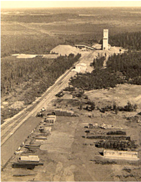
Vihannin kaivoksen Ristonahon apukuilun nostotorni
