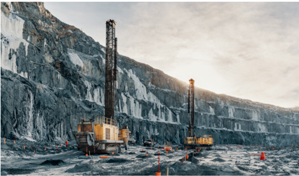
Pohjaveden suojapumpaukset osana ympäristövaikutusten hallintaa
